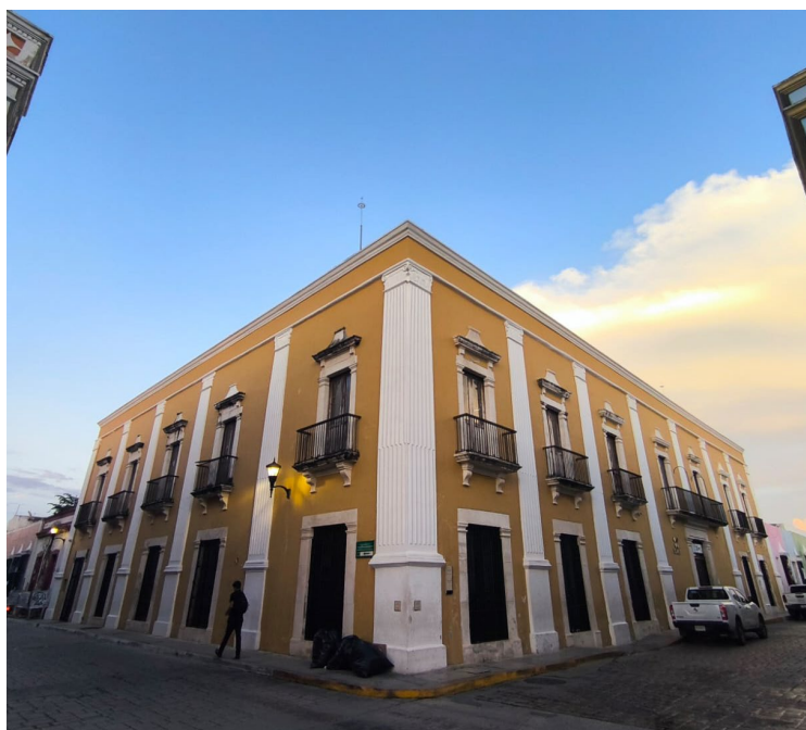
Foto 13. Segundo edificio de la Academia Normal para Profesoras y tercera ubicación de la Escuela Modelo 2 para señoritas entre 1910 y 1914, ubicada en calle 51 no. 27, colonia centro, San Francisco de Campeche, Campeche. Fotografía de mi autoría.
