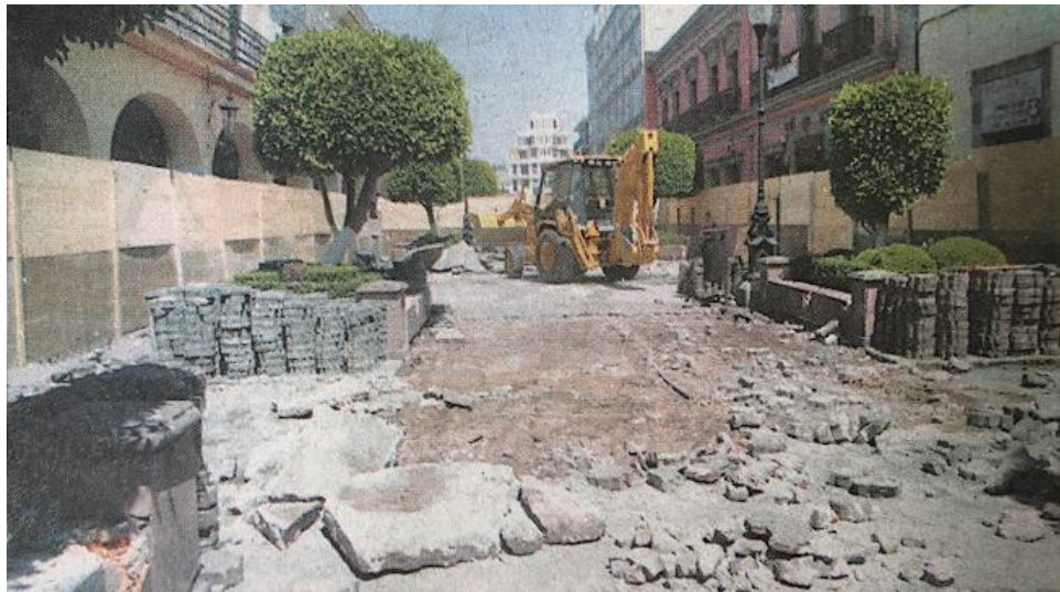
Figura 27. Fotografía de la remodelación del Andador Constitución, 2008.
