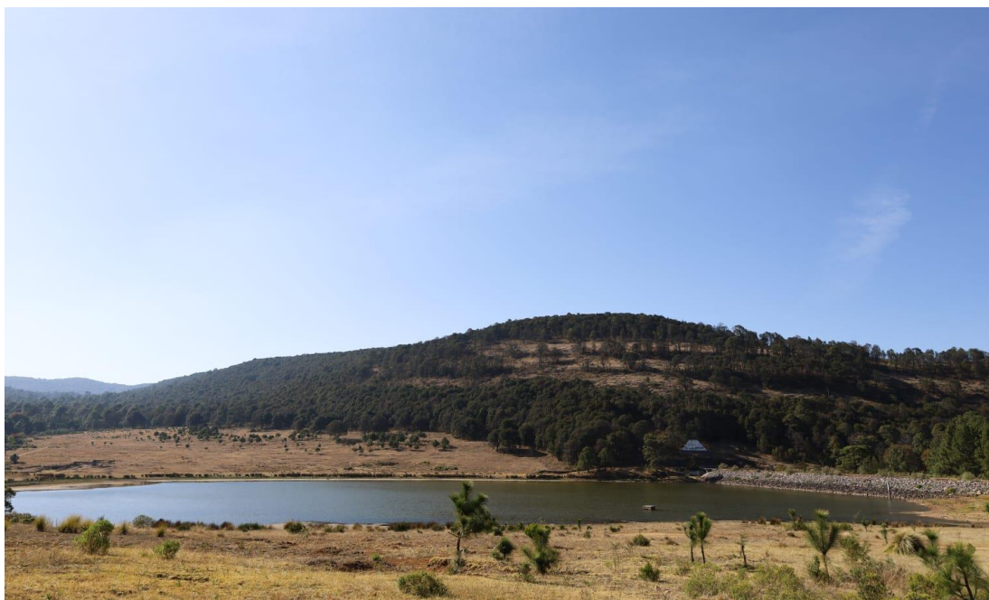
Fotografía 1. Presa El Puerto de Tixmadejé
