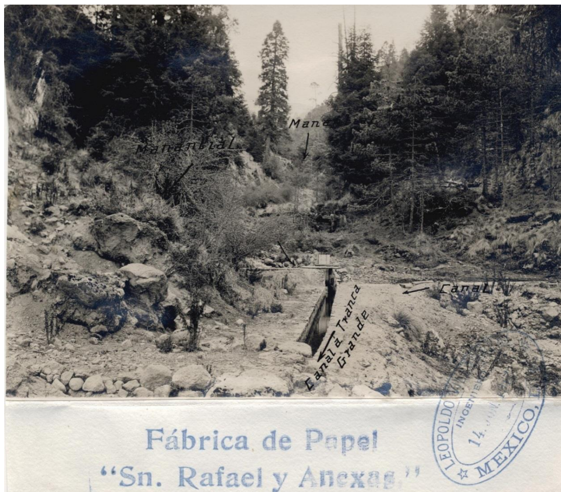
Imagen 8. Canal de "Tranca grande" que transportaba las aguas para represarlas en "La cuesta". Fuente: AHA, Aprovechamientos Superficiales, Caja 260, Exp. 6263, Legajo 2, F. 82 y 88.
