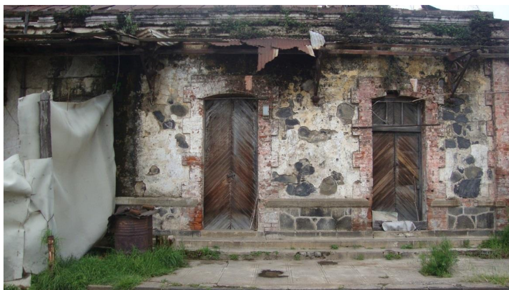
Imagen 3. Vista actual de la Antigua estación Apatlahuaya del ferrocarril que corre entre Tlalmanalco y Amecameca, que se uniría, aproximadamente un kilómetro más adelante, a los cuatro kilómetros que construye la fábrica papelería San Rafael en 1890.
