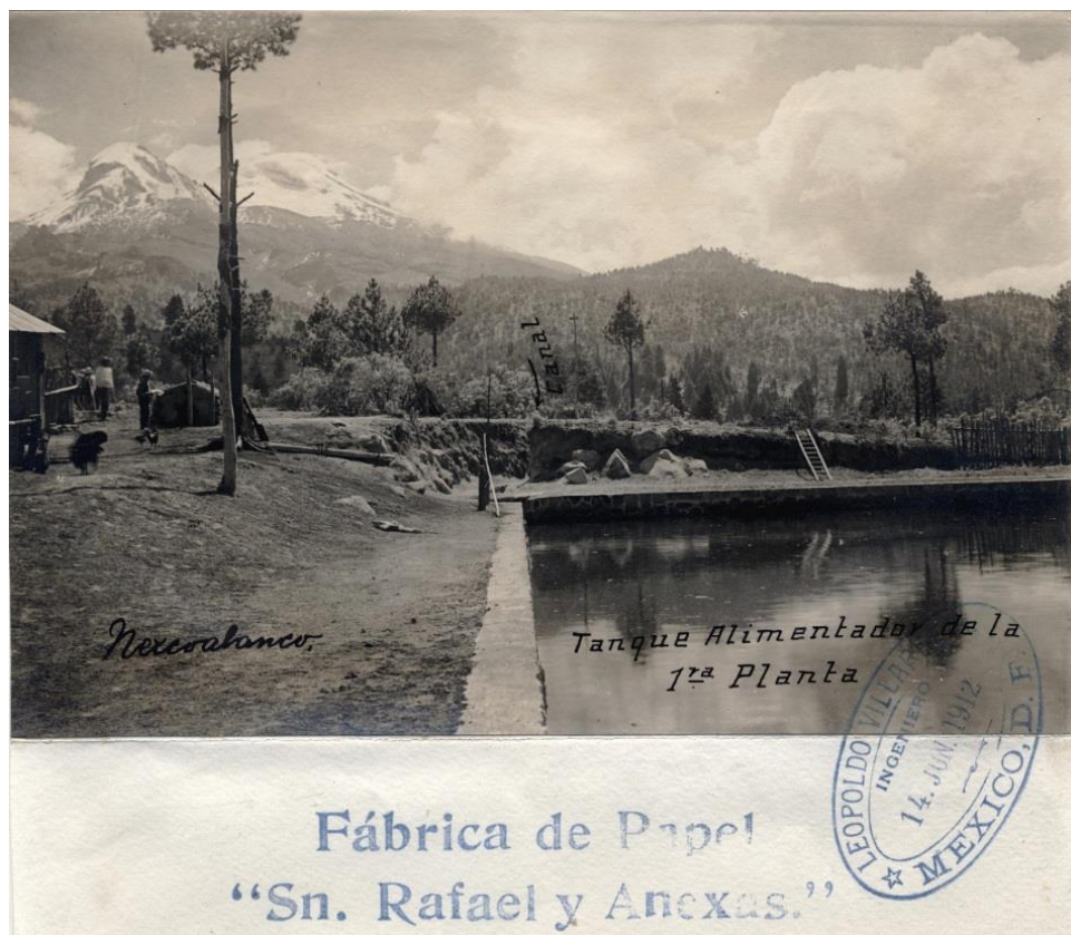
Imagen 28. Uno de los tanques alimentadores de la planta que servía para eliminar impurezas en el agua utilizada durante el proceso de industrialización. Fuente: AHA, Aprovechamientos Superficiales, Caja 260, Exp. 6263-2 F.81.
