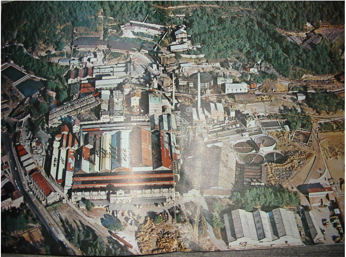
Imagen 31. Instalaciones de la “Compañía de las Fábricas de Papel San Rafael y Anexas, S.A.”. Fuente: Grupo Atlixco.
