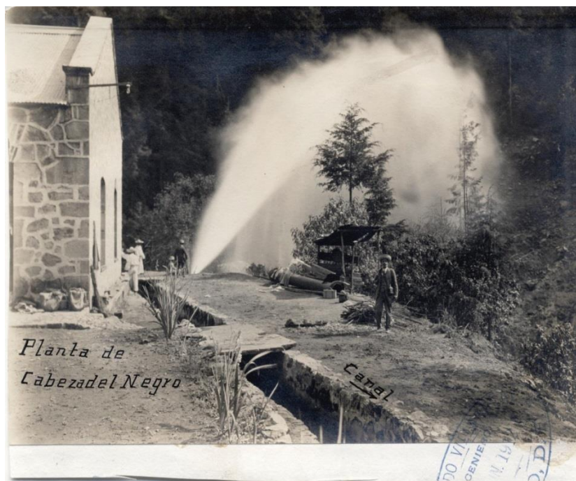
Imagen 10. Planta eléctrica "Cabeza de negro" que hacía uso del agua represada en la presa del mismo nombre para generar energía motriz que se convertía después en energía eléctrica. Fuente: AHA, Aprovechamientos Superficiales, Caja 260, Exp. 6263, Legajo 2, F. 94.
