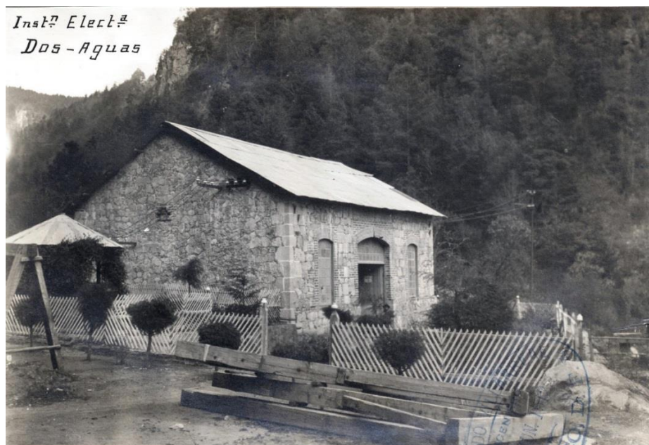
Imagen 11. Planta eléctrica "Dos aguas" que hacía uso del agua represada en la caja del mismo nombre para generar fuerza motriz que se convertía después en energía eléctrica. Fuente: AHA, Aprovechamientos Superficiales, Caja 260, Exp. 6263, Legajo 2, F. 87.
