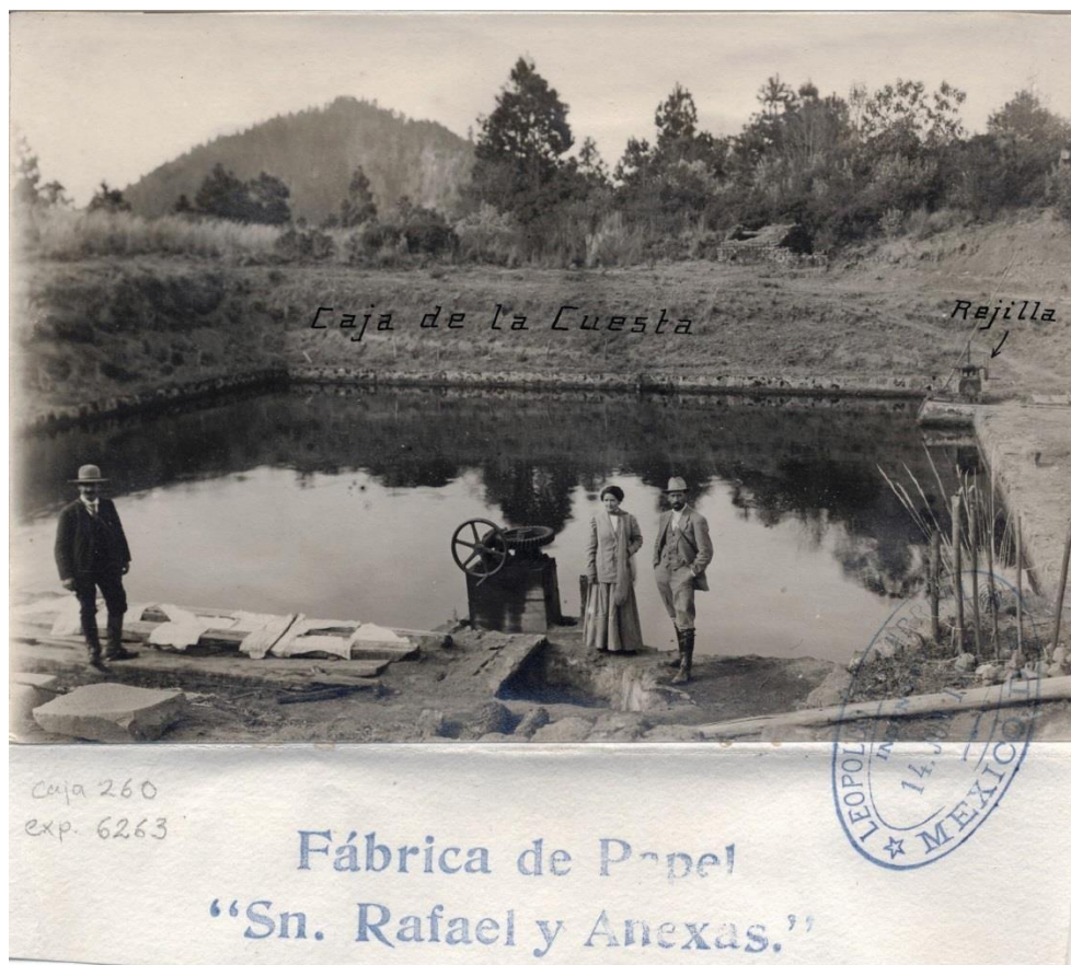
Imagen 7. Caja de agua "La cuesta" que reunía las aguas de los canales uno y dos. Fuente: AHA, Aprovechamientos Superficiales, Caja 260, Exp. 6263, Legajo 2, F. 89.
