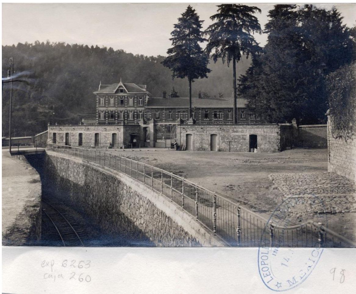
Imagen 20. Infraestructura para el recorrido del ferrocarril dentro de las instalaciones de la fábrica de papel San Rafael. Circa, 1940. Fuente: AHA, Aprovechamientos Superficiales. Expediente 260-6263. Foto 98.
